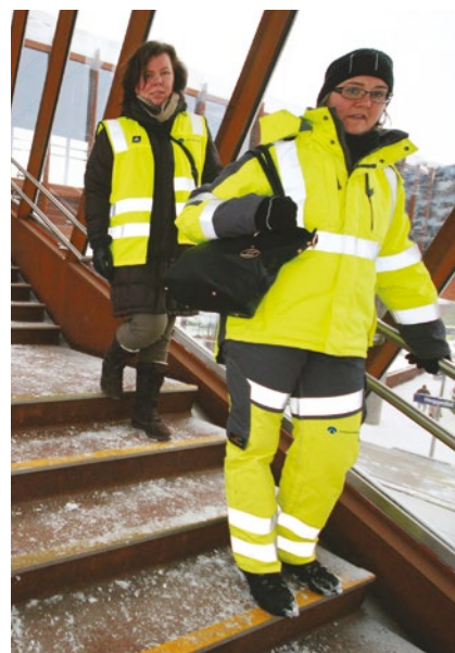
Trappenesene er merket med god kontrastfarge, og rekkverket er i to høyder.
