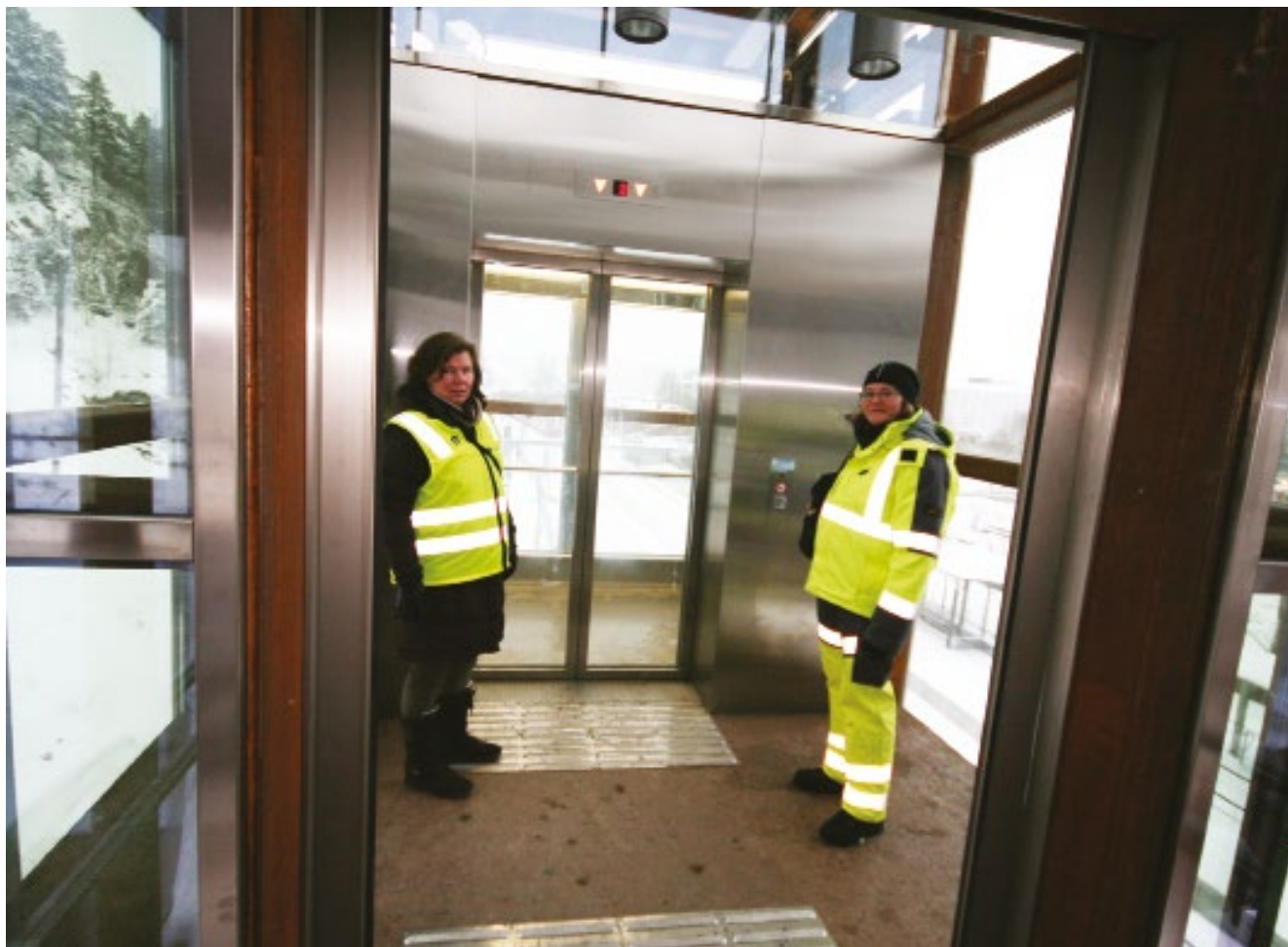
Heggedal stasjon har fått et nytt heishus med automatiske dører og tydelige oppmerksomhetsfelt.
