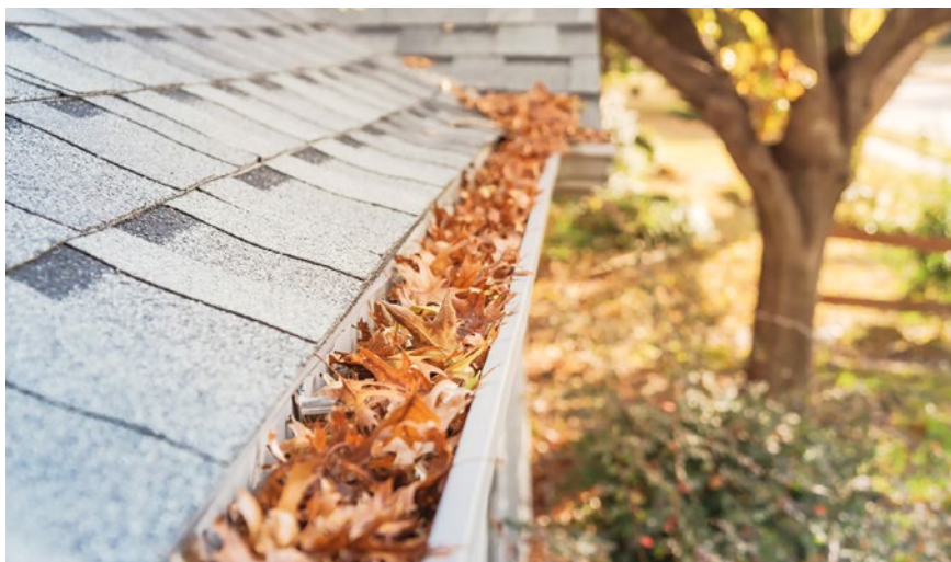
Taket er husets viktigste beskyttelse mot vær og vind.
